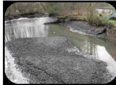
Embâcle à Lormaye, source photo : CD 28
