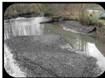
Embâcle à Lormaye, source photo : CD 28
